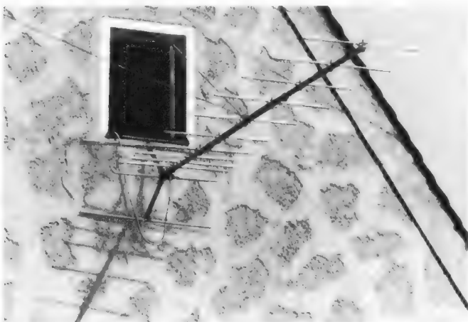
In Ausnahmefällen kann man durch den Montageort der Antenne ein besseres Vor-Rück-Verhältnis erzielen; in diesem Fall schirmt das Haus den störenden, von rückwärts einfallenden Sender ab
